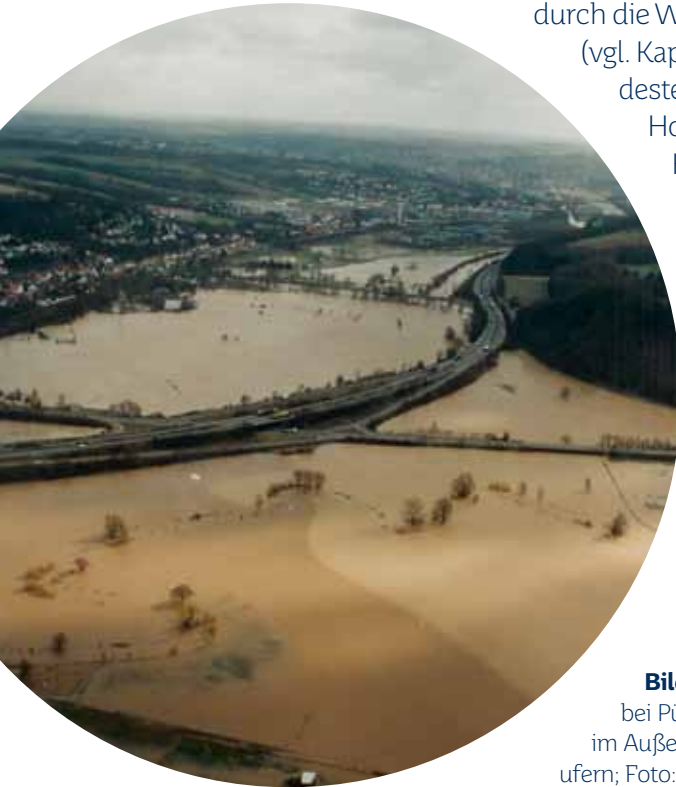
Bild Seite 6: Luftbild Schwarzbachmündung: Blies (von links kommend nach rechts fließend) und Schwarzbach (von oben kommend) in Homburg-Einöd am 27.02.1997; Foto: LUA
